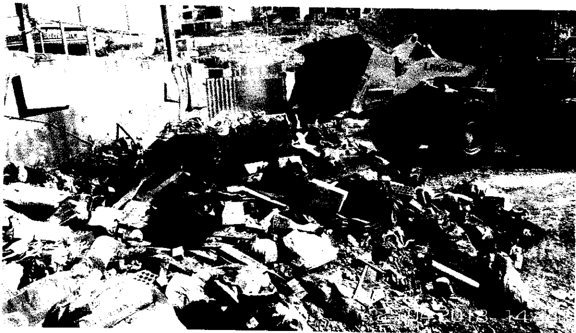
CARGUÍO DE ESCOMBROS Y ELIMINACIÓN DE SÓLIDOS
